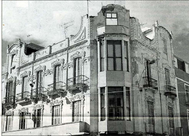
Estado actual del edificio de las calles Pareja-Prim
